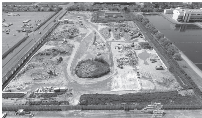
写真1 西日本豪雨 倉敷市解体廃棄物一次仮置場
