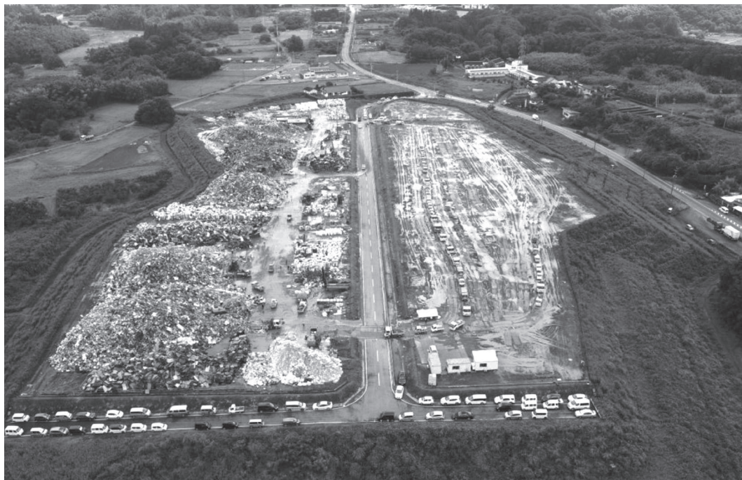
写真3 令和2年7月豪雨 人吉市仮置場
