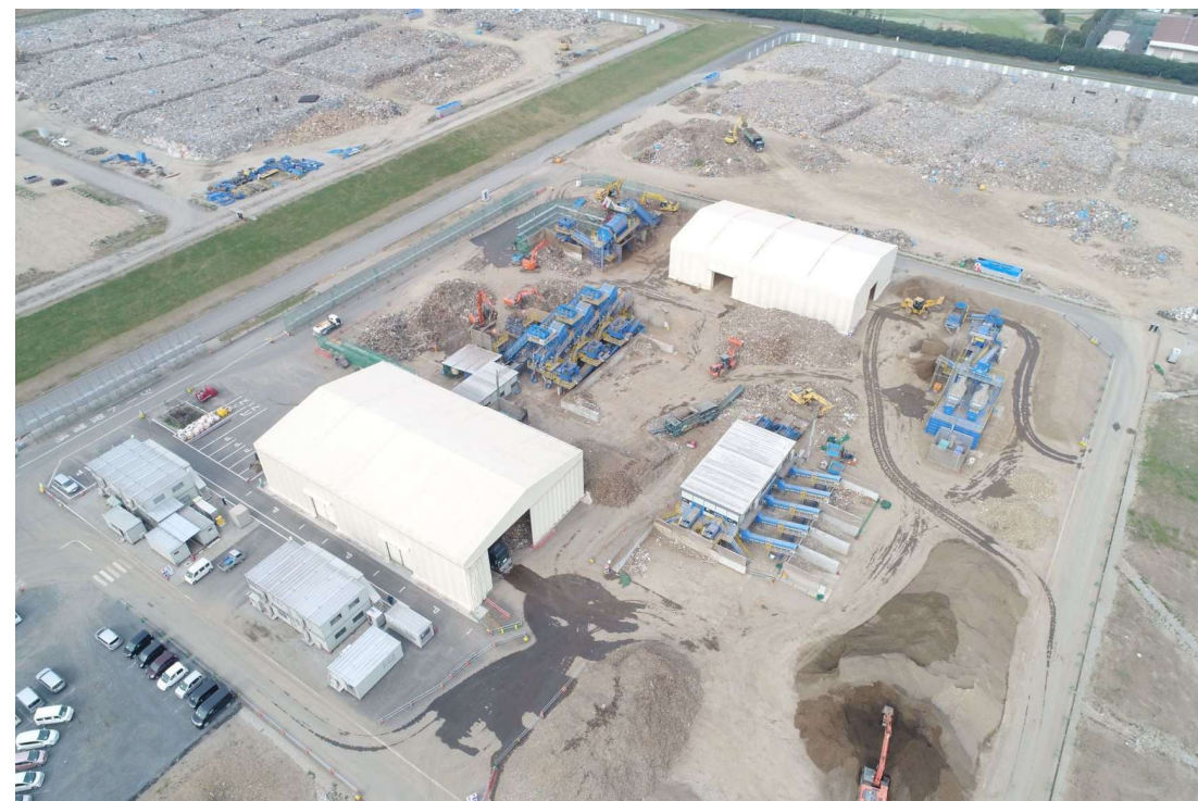
二次仮置場全景
