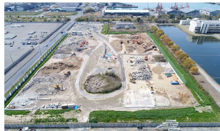
一次仮置場全景
