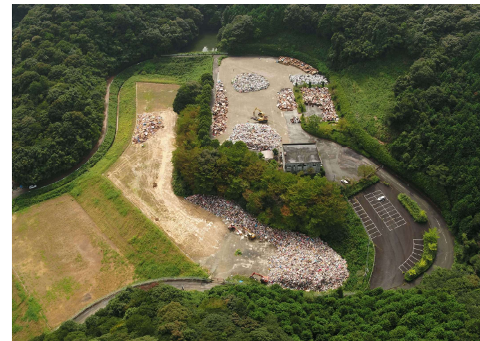
二次仮置場全景
